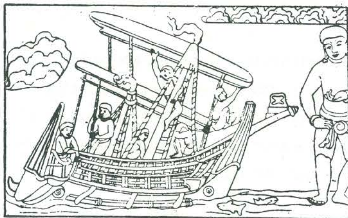
插圖十六 船兩桅都有梯級，三根稍爲彎曲的檔木，假定繫結在兩浮木上
