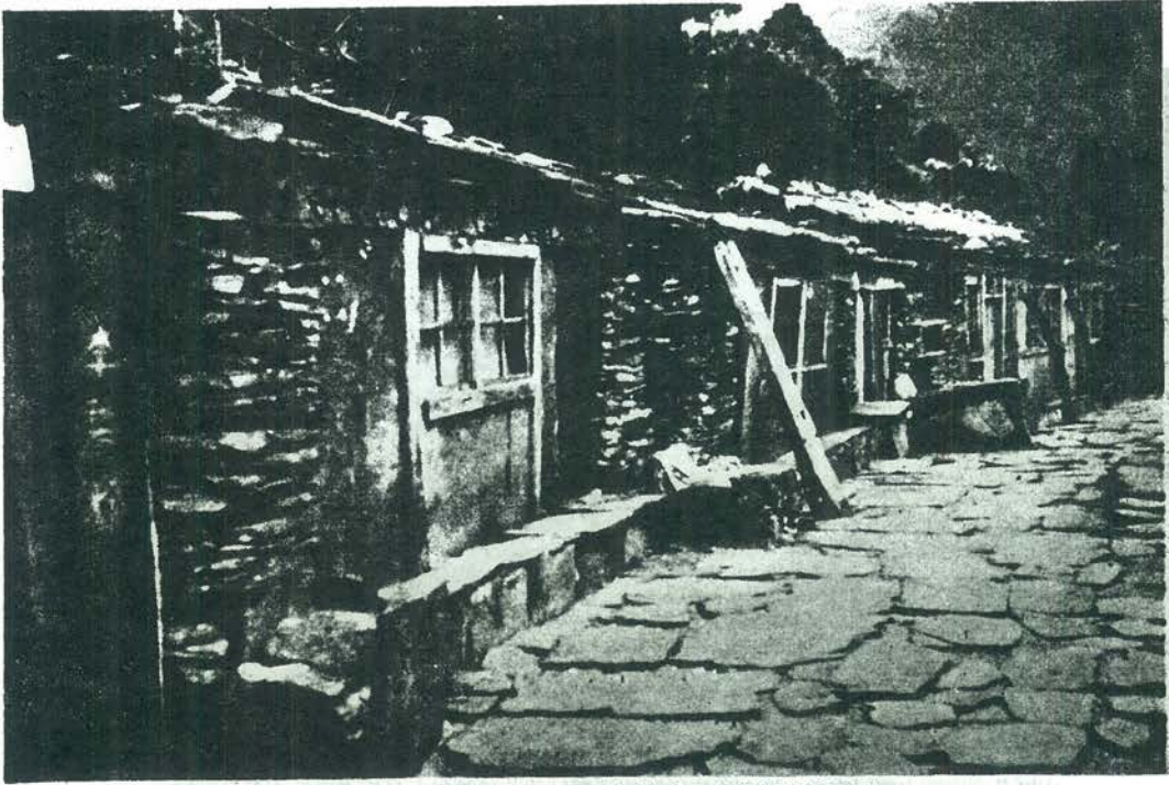
魯凱人所住石板矮房。1965年8月筆者攝於屏東霧臺鄉好茶村。 Slate-built dwellings in Kochiyabogan. (photo J. Y. Wang)
